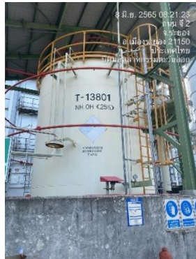
ภาพที่ 2-30 ถังเก็บสารละลาย \text{NH}_4\text{OH}
