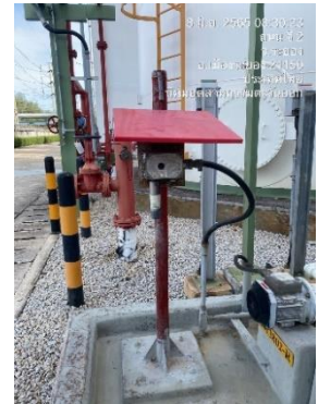
ภาพที่ 2-31 Gas Detector และ Ammonia Detector
