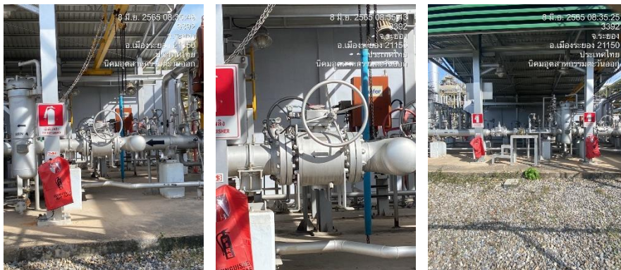
ภาพที่ 2-36 วาล์วควบคุมการจ่ายก๊าซ
