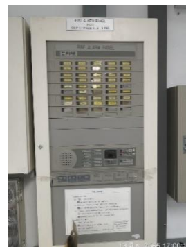
ภาพที่ 2-32 ตู้ควบคุมสัญญาณเตือนต่างๆ
