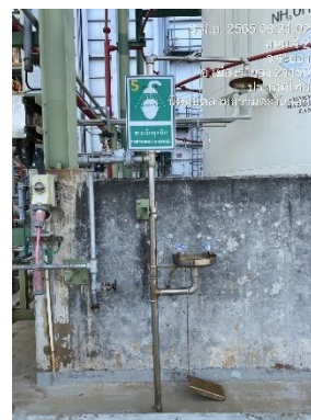
ภาพที่ 2-25 อ่างล้างตาและฝักบัวฉุกเฉิน
