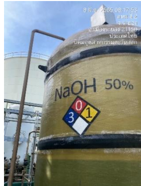
ภาพที่ 2-27 ถังเก็บสารละลาย NaOH
