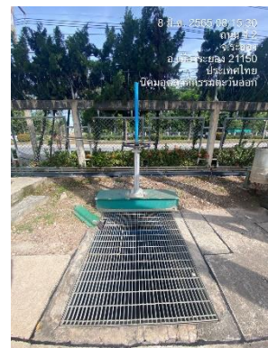
ภาพที่ 2-9 ประตูปะบายน้ำของรางระบายน้ำฝน
