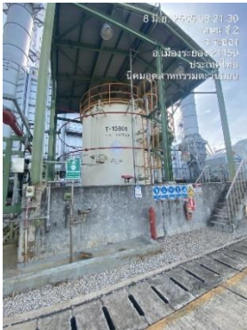
ภาพที่ 2-30 ถังเก็บสารละลาย \text{NH}_4\text{OH}
