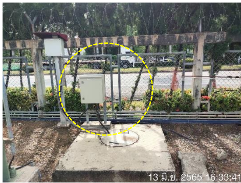
ภาพที่ 2-3 การติดตั้งอุปกรณ์เพื่อนำน้ำทิ้งกลับมาใช้ประโยชน์
