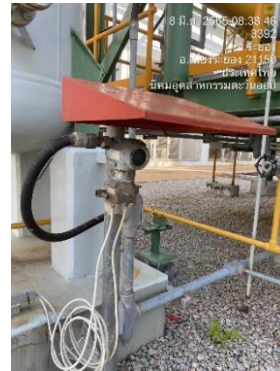
ภาพที่ 2-31 Gas Detector และ Ammonia Detector
