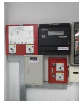
ภาพที่ 2-31 Gas Detector และ Ammonia Detector
