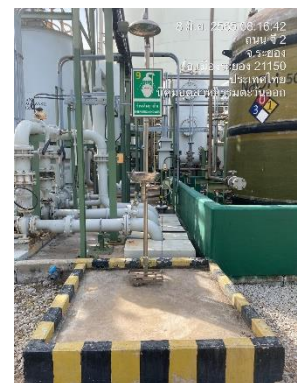
ภาพที่ 2-25 อ่างล้างตาและฝักบัวฉุกเฉิน
