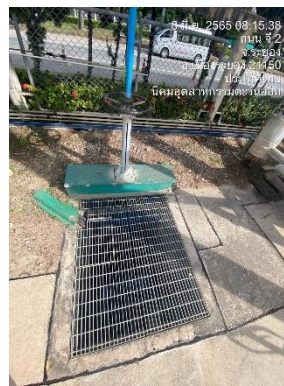
ภาพที่ 2-9 ประตูปะบายน้ำของรางระบายน้ำฝน
