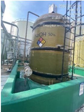
ภาพที่ 2-27 ถังเก็บสารละลาย NaOH
